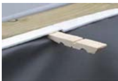
Abbildung 28 – Verklebung der Folienauskleidung mithilfe der halben Wäscheklammern
