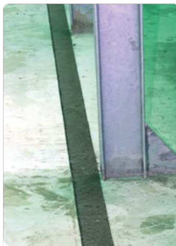
Abbildung 7 – Schaffung der Bitumenstreifen
