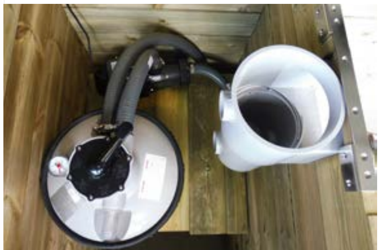
Anschluss des Filtersystems Filter / Pumpe / Saugung / Einlauf
