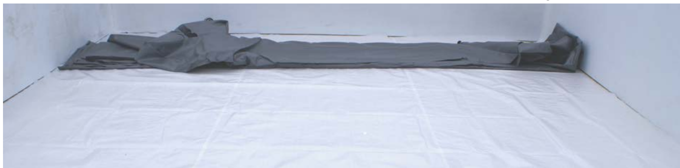
Abbildung 27 – Entfalten der Folienauskleidung
