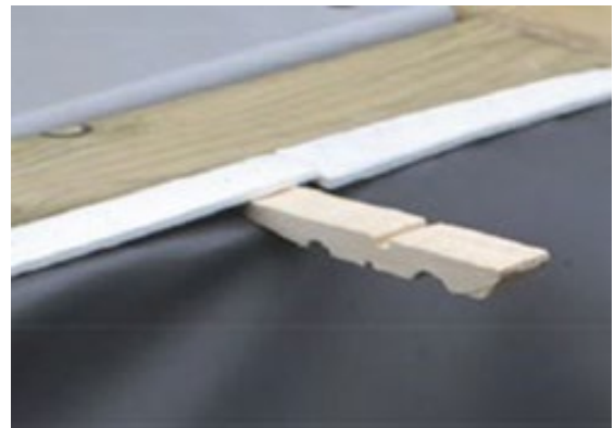
Abbildung 31 – Verlegung der Folienauskleidung mithilfe der halben Wäscheklammern
