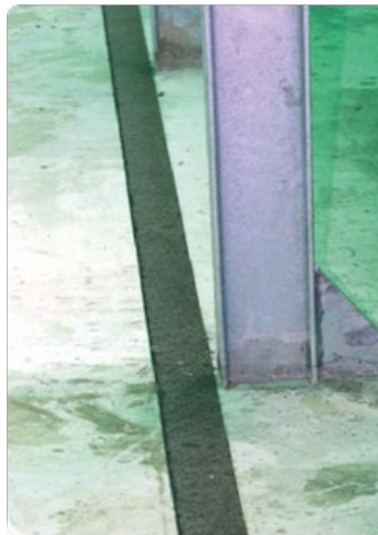
Abbildung 8 – Anbringen der Bitumenstreifen
