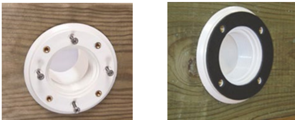
Abbildung 24 – Montage des Gehäuses der Einlaufdüse und der Dichtung
