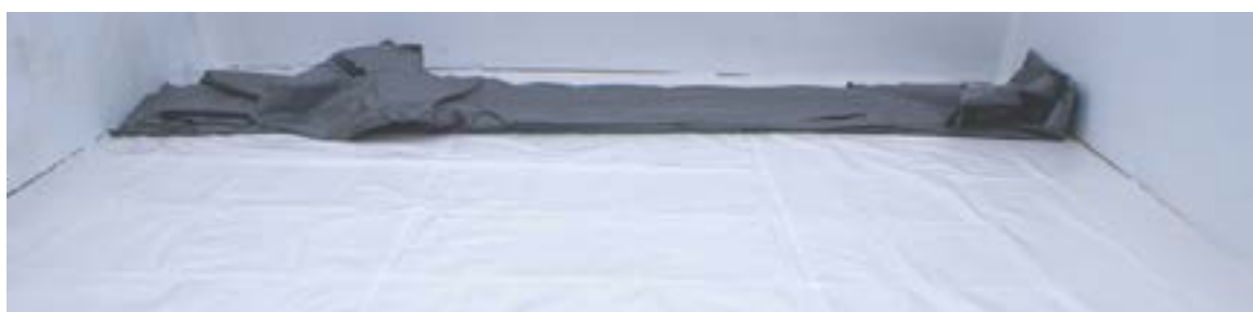
Abbildung 33 – Entfalten der Folienauskleidung
