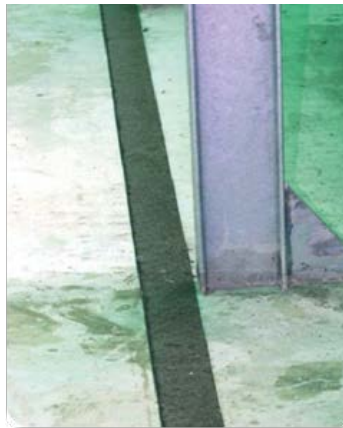
Abbildung 8 – Anbringen der Bitumenstreifen
