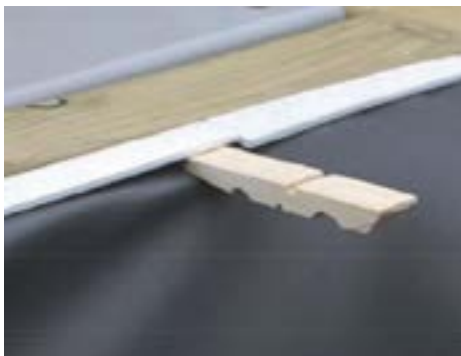
Abbildung 32 – Verteilung der Folienauskleidung mithilfe der halben Wäscheklammern
